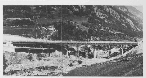
Ansicht der Brücke talabwärts kurz vor der Fertigstellung. Der Pfeil markiert den abgesackten Pfeiler der Talspurbrücke. Unten links erkennt man die Mauern einer Jahrzehnte alten Bachverbauung
