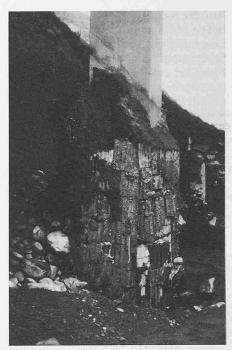
Bild 5. Freigelegtes Schachtfundament
