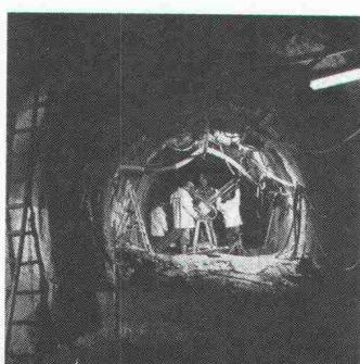
Im Hirschengrabentunnel der S-Bahn in Zürich werden instabile Lockergesteinszonen mittels spezieller Bauhilfsmassnahmen sichergestellt.
