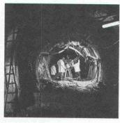
Im Hirschengrabentunnel der S-Bahn in Zürich werden instabile Lockergesteinszonen mittels spezieller Bauhilfsmassnahmen sichergestellt.
