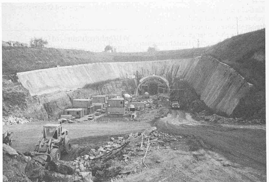
Bild 3. Voreinschnitt West des Rollenbergtunnel
