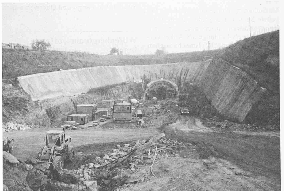
Bild 3. Voreinschnitt West des Rollenbergtunnel
