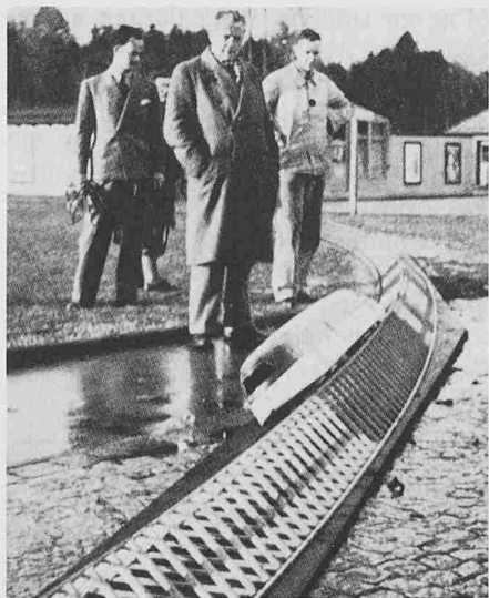
Bild 12. Modell 1:10 der von Prof. K. Wiesinger (ETHZ) vorgeschlagenen entgleisungssicheren Ultraschnellbahn im Strandbad Wollishofen (Glaser's Annalen, H. 15, 1. 8. 1939)
