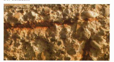
Betonabplatzungen infolge starker Armierungskorrosion.
