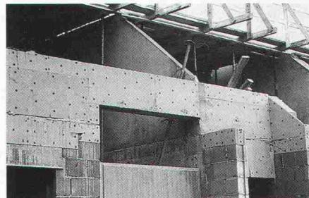
dämmung mit Styrodur:
