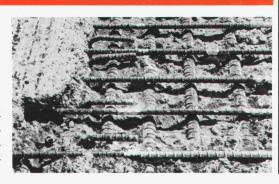
Damit entstehen optimale Voraussetzungen für die Rostschutzbehandlung der Armierung, für die Reprofilierung mit Spezialmörteln für den Oberflächenschutz zur Verhinderung von neuen Schäden.
