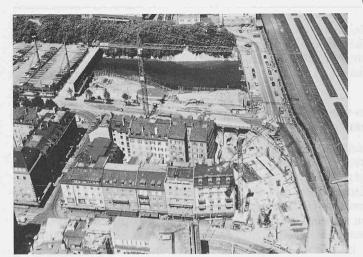
Die Baugrube beim Hauptbahnhof, wo unter einer Betondecke am Tunnelausbau (links) und an der Station Shopville gearbeitet wird. Darüber werden später der Erweiterungsbau des Shopvilles und der Neubau des «Habis Royal» liegen (Fotos Comet)
