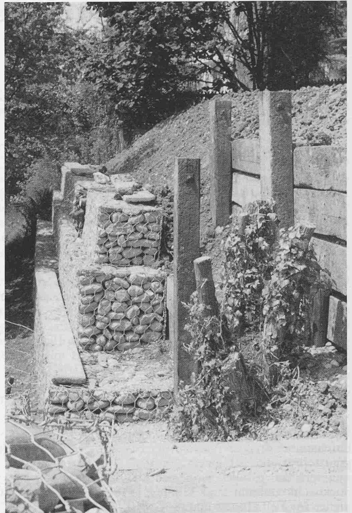
Steinkörbe, Bahnschwellen, bestehende noch begrünte Gehölz-Strünke, Fallholz als Geländeverbauung mit Treppe
