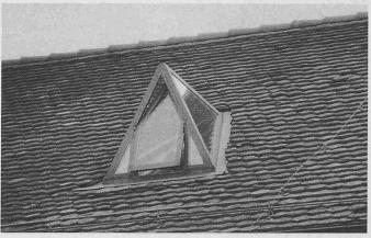
Dachgaube: Pyramidenform, völlig verglast, mit Schwingflügelfenster
