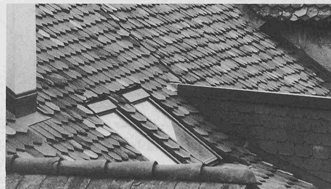
Dachflächenfenster durch Anpassung des Eindeckrahmens abgesenkt: Rahmenhöhe entsprechend Ziegelhöhe
