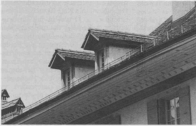
Herkömmliche Lukarnen: Riegkonstruktion sichtbar, Felder ausgemauert und verputzt, kräftiges Sturzprofil, Satteldach
