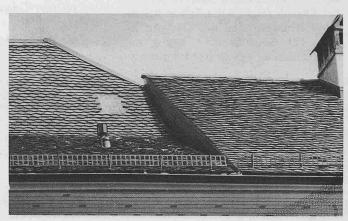
Glasziegel (anstelle eines Dachflächenfensters) mit in der Ebene der Wärmeisolation liegendem, klappbarem Isolierfenster
