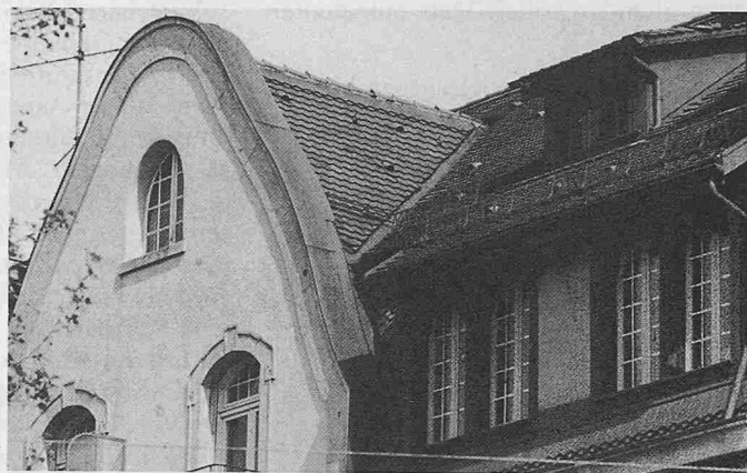
Schlepper: genügender seitlicher und vorderer Dachvorsprung, dem Bedachungsmaterial angepasste Farbgebung
