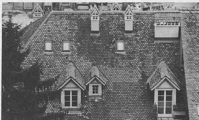
Lebhafte Mischung von Lukarnen (Grösse der Funktion angepasst) und Dachflächenfenstern (in der Grösse an der oberen Grenze)
