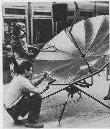
Schüler mit dem entwickelten Objekt, das zur Verbesserung der Infrastruktur im Gesundheitswesen von Entwicklungsländern beitragen soll. Der Parabolspiegel erzeugt auf einfache Weise Hitze zur Sterilisation von Instrumenten. Der Sterilisationsbehälter hängt im Brennpunkt der zentrierten Sonnenbestrahlung.
