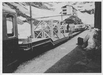
Für sperrige, lange Transportgüter wurde ein Tiefgangwagen eingesetzt, hier mit zwei Elementen des zerlegten Baukrans
