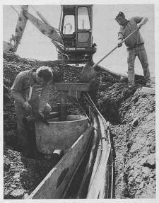
Unterhalb des Tunnels der Jungfraubahn ist die Abwasserleitung neben elektrischen Leitungen und verschiedenen Werkleitungen im Boden verlegt. Kontrollschacht der Abwasserleitung mit Überdruck-
