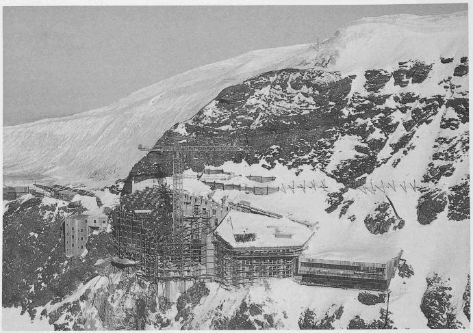
Gesamtübersicht. Auf dem rechten Teil des Berghauses ist das Unterdach in Holz bereits angebracht und die Fassade montiert, die Dachaussparung zeigt den Ort, wo der zweite Baukran demontiert wurde. Im linken, westlichen Teil ist die Stahlbaumontage im Gang. Auf dem Joch fallen 10 bis 15 m Schnee pro Jahr
