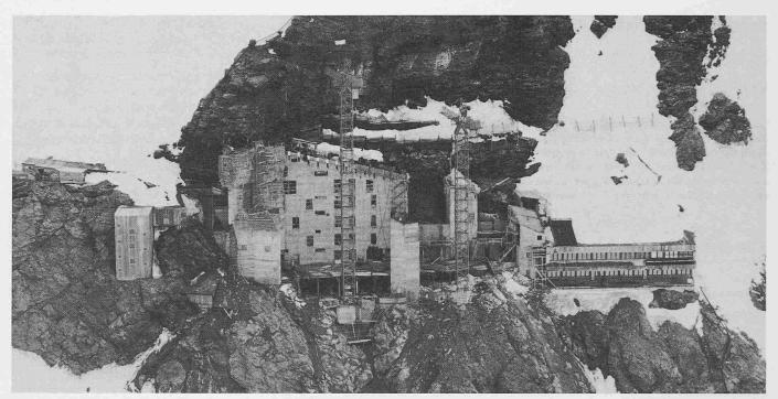
Gesamtübersicht über die Baustelle etwa 2½ Jahre nach Baubeginn. Gut sichtbar ist die wegen der Lawinengefahr nach Westen abgewinkelte Rückwand des Berghauses. Rechts das bestehende Gletscherrestaurant, ursprünglich ein Provisorium für etwa 10 Jahre, das umgebaut, in den Neubau integriert und damit zum «Providuri-
