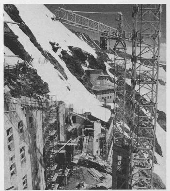
Zwei speziell für das Jungfraujoch konstruierte Baukrane wurden - wie alle andern Bauteile in kleine Elemente zerlegt - mit der Wengernalpbahn und der Jungfraubahn auf 3450 m Höhe transportiert. Für den Kranführer eine verantwortungsvolle Aufgabe hoch über dem Aletschgletscher; die Höhe des Aufstiegs über die vereiste Stahlleiter zur Krankabine unterstrich diese Verantwortung
