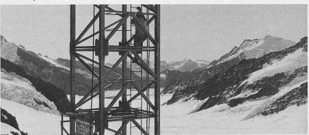
Die Rückwand des Berghauses ist etwa 25 m hoch und 35 cm dick, in armiertem Beton im Gleitschalverfahren erstellt. Um das Betonieren bei Temperaturen bis -20 °C zu ermöglichen, wurde die ganze Konstruktion eingepackt. Verschiedenemale zerfetzten Sturmböen die Verschalung
