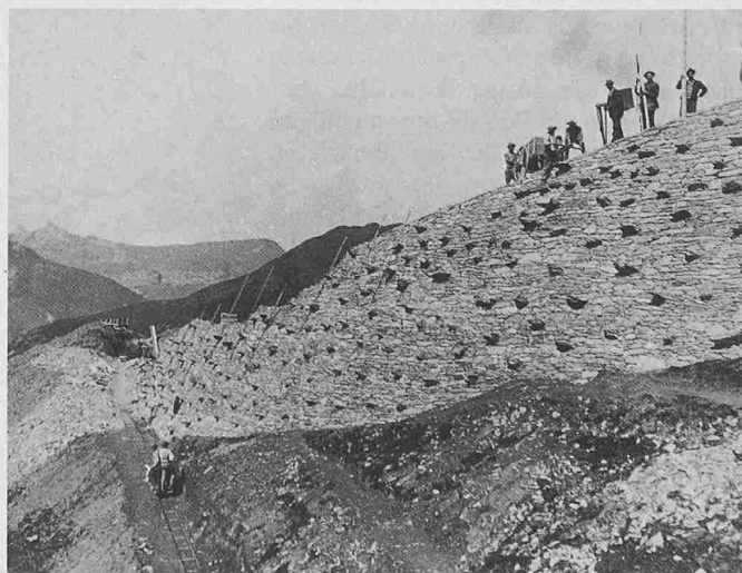
Stützmauerbau auf dem Eigergletscher
