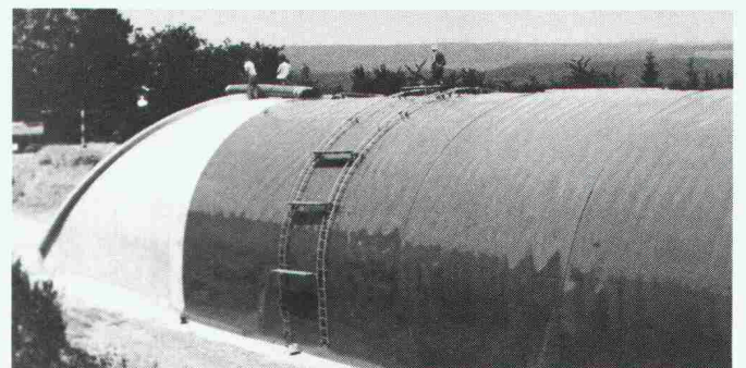
Tunnel «Nordumfahrung Zurzach» – zur Zeit in Ausführung: abgedichtet mit 30 000 m 2 Sarnafil Typ FP 4 mm.
