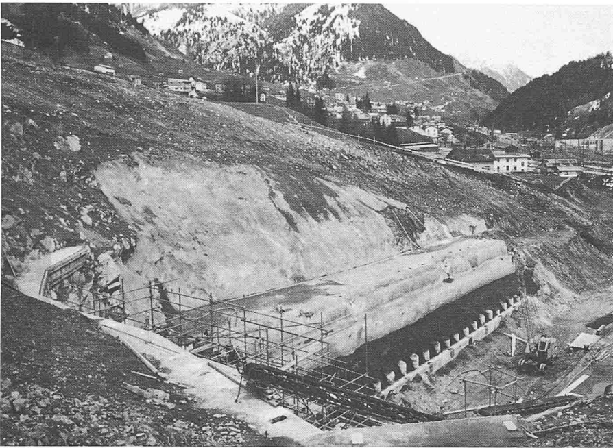
Bild 3. Böschungssicherung mit Spritzbeton (RIA-Foto, Zürich)
