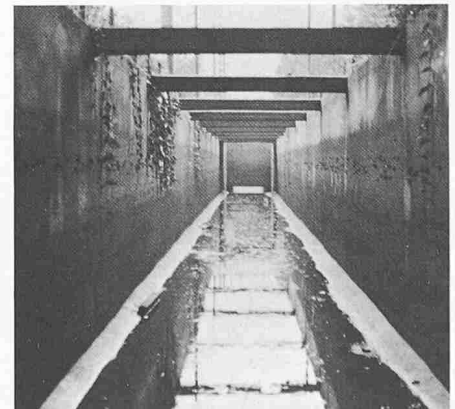
Bild 19. Mit Spritzbeton ausgekleideter Kraftwerkkanal. Reparatur und Abdichtung
