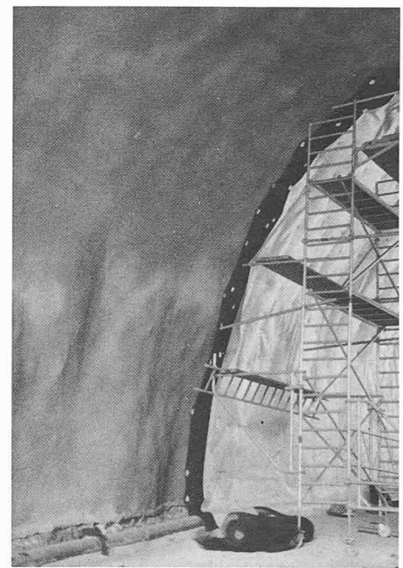
Bild 11. Mit Spritzbeton ausgekleideter Tunnel. Tragschicht der Abdichtung
