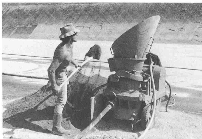
Bild 2. Spritzbetonmaschine. Maschinist beim Einfüllen des Trockengemisches
