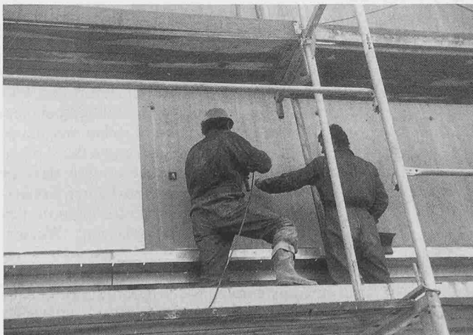
Bild 4. Montage der Dichtungsbahn
