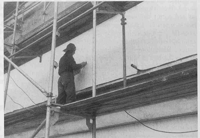
Bild 5. Verschweissen der Bahnstösse
