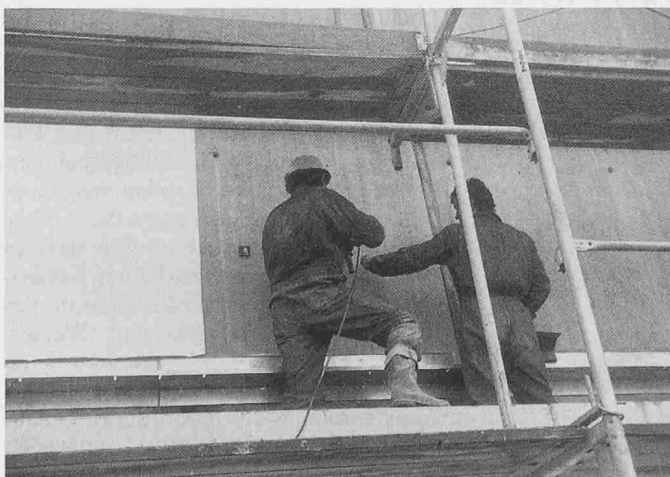
Bild 4. Montage der Dichtungsbahn
