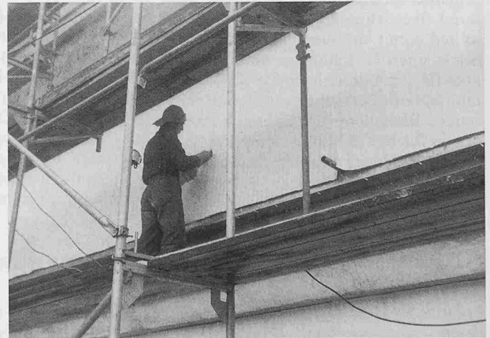
Bild 5. Verschweissen der Bahnstösse
