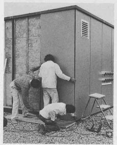
□ Dissipationswirkung, was die sommerliche Hitze betrifft: Die Hitze, die in dieses System eintritt, wird durch den Reflex der Verkleidungsplatte, durch die Konduktion derselben und durch die Ventilierung vermittels der Luft, die sich im Zwischenraum zwischen Verkleidung und Wärmedämmung befindet, dissipiert, so dass die Restwärme, die in das Innere des Gebäudes gelangt, wirklich von geringem Ausmass ist.
