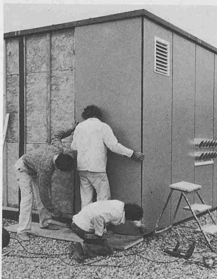
Montage der MEG-Fassadenplatten bei Liftaufbau
