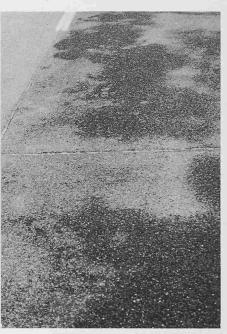
Bild 12. Rauhbetonbelag auf der rechten Strassenhälfte. Linke Hälfte mit üblicher Fertigung der Belagsoberfläche
