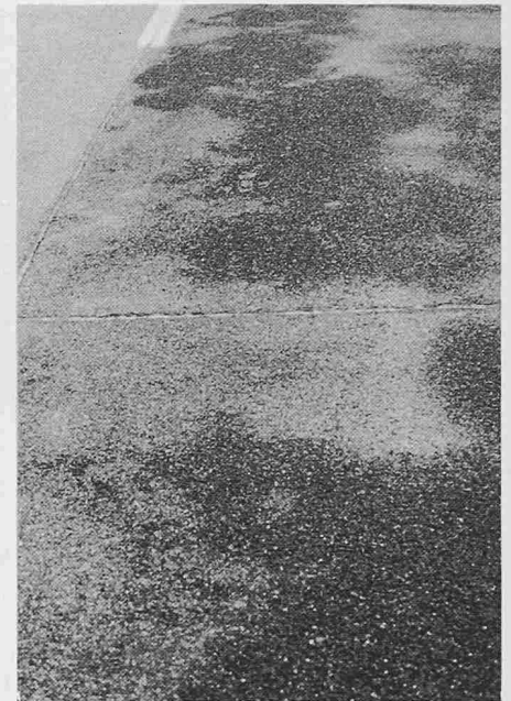
Bild 12. Raubbetonbelag auf der rechten Strassenhälfte. Linke Hälfte mit üblicher Fertigung der Belagsoberfläche
