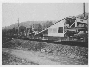
Bild 14. Betonzug des Hauenstein-Basistunnels
