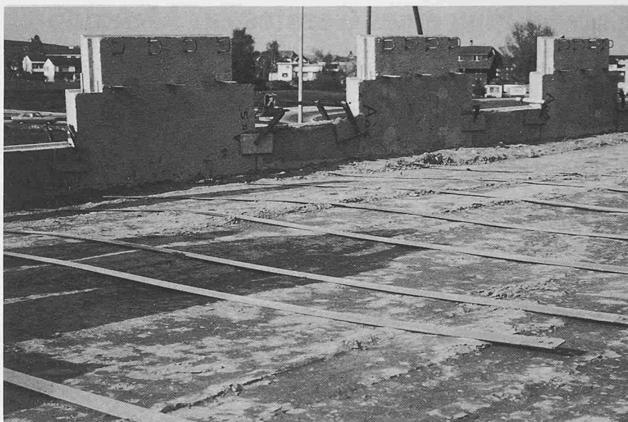
Mur de soutènement selon la technique de la terre armée: un exemple d'innovation permettant des constructions rapides et économiques
