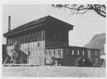
Der grösste noch erhaltene «Hänggiturm» der Schweiz in Ennenda GL wird zurzeit «sanft» abgebrochen: Ziegel für Ziegel, Balken für Balken werden einzeln abgetragen und numeriert. (Foto Schönwetter, Glarus)
