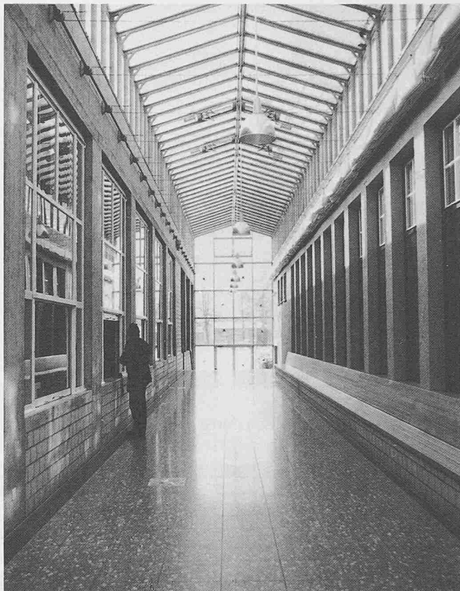
Blick in die verglaste Zuschauergalerie. Rechts die Fassade der alten Turnhalle, links die innere Fassade der neuen Halle. Die Galerie ist mit einer horizontalen Schattiervorrichtung ausgestattet
