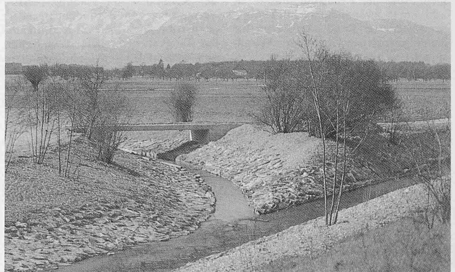
Bild 4. Neuer Kanal bei Aristau, Einmündung Wissenbach in den Reusskanal
