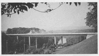
Bild 5. Das 50 m hohe Reusstalviadukt (N 1/418) gestattet mit seinen wenigen schlanken Stützen den Durchblick auf die Reuss
