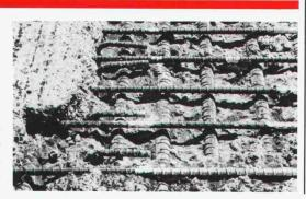
Damit entstehen optimale Voraussetzungen für die Rostschutzbehandlung der Armierung, für die Reprofilierung mit Spezialmörteln für den Oberflächenschutz zur Verhinderung von neuen Schäden.
