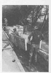
sionen. Hervorzuheben ist der aufsteckbare Geländepfosten. der zum System gehört und zuwangsläufig eine vorschrifts-mässige Baustellenabschrankung gewährleistet.
