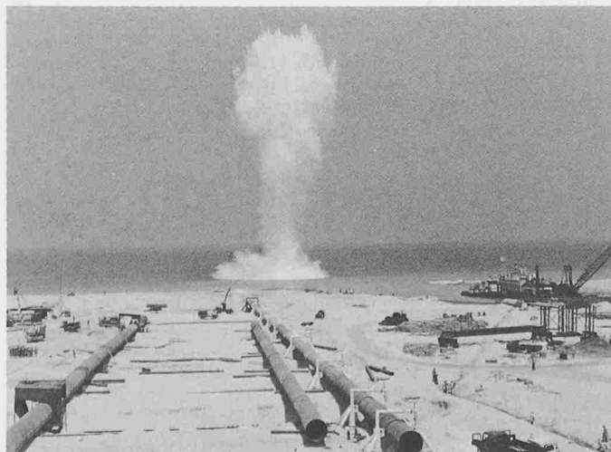
Bild 1. Unterwassersprengungen erschüttern das Baugelände und bedingen präzise Setzungs-Messungen
