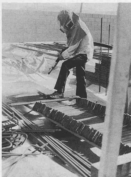
Bild 3. Systematisches Sandstrahlen der Armierungseisen vor dem Verlegen
