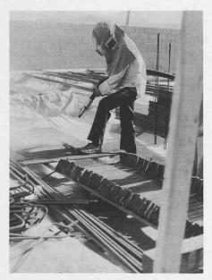
Bild 3. Systematisches Sandstrahlen der Armierungseisen vor dem Verlegen
