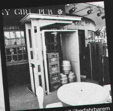
z.B. Unterfluraufzüge mit überfahrbarem Schachtabschluss - wenn der Aufzug nicht ins Gebäude eingebaut werden kann.
