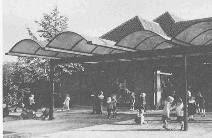
lich (Hagelgarantie), garantiert lichteht, ausgezeichnete Lichtdurchlässigkeit; lieferbar transparent, weiß opal und bronze-farben, leicht im Gewicht, einfach in der Verarbeitung, kalt verformbar, isolierend, bis zu 50% bessere Isolation gegenüber Massivglas mit gleicher Stärke.
