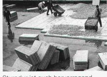
Styrodur ist auch hervorragend geeignet für die Steildach-, Kern-, Boden- und Perimeterdämmung, für die Dämmung von Parkdecks, Hallen und Kühlhäusern, für den Gleis- und Straßenunterbau und für viele andere Bauanwendungen.
