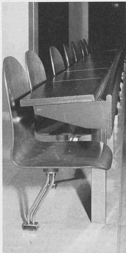
Bild 4. Pultkantenanslässe im grossen Hörsaal der Universität Zürich-Irchel (Werkfoto Sulzer)
