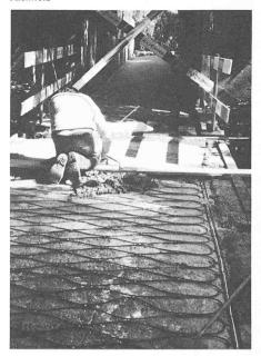
Das Schutzpotential, gemessen nach Ausschalten des Schutzstromes, wird über 4 Stunden mit registrierenden Messinstrumenten aufgezeichnet und mittels eines Rechenprogrammes ausgewertet. Die Kontrollmessungen erfolgen im ersten Betriebsjahr alle drei Monate und in den folgenden Jahren alle sechs Monate.
