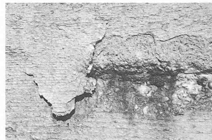
Bild 3. Aufgeplatzte Betonoberfläche
