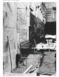
filterstabilen Sickermatte Enkadrain, die überall dort eingesetzt wird, wo aus bautechnischen und wirtschaftlichen Gründen ohne Raumverlust gegen das Terrain (Fels, Rühlwand usw.) betoniert wird. Enkadrain CK besteht aus
