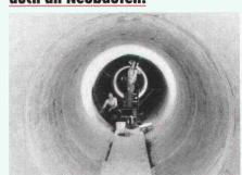
Hier werden Stossfugen am Kabelschacht unter den Geleiseanlagen des Bahnhofs Luzern für einen sicheren Betrieb hundertprozentig abgedichtet.
