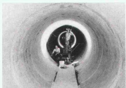
Hier werden Stoßfugen am Kabelschacht unter den Geleiseanlagen des Bahnhofs Luzern für einen sicheren Betrieb hundertprozentig abgedichtet.
