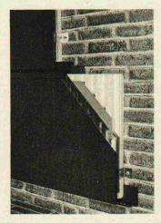
System enthält bausatzartig Anschlüsse an Fenster, Türen, Ekken aus Farb-Alu. Erhältlich in verschiedenen Farbtönungen. Gewicht unter 5 kg pro m². Schweizer Produkt.
