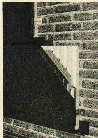
System enthält bausatzartig Anschlüsse an Fenster, Türen, Ecken aus Farb-Alu. Erhältlich in verschiedenen Farbtönen. Gewicht unter 5 kg pro m<sup>2</sup>. Schweizer Produkt.
