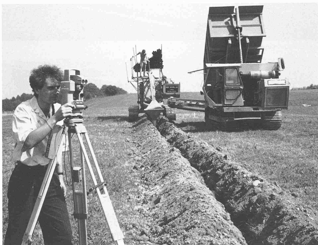
Das Bild zeigt eine Kombination der Fachbereiche Kulturtechnik und Vermessung: Im Vordergrund eine moderne Vermessungsstation, im Hintergrund eine lasergesteuerte Grabenfräse beim Verlegen von Drainrohren.
