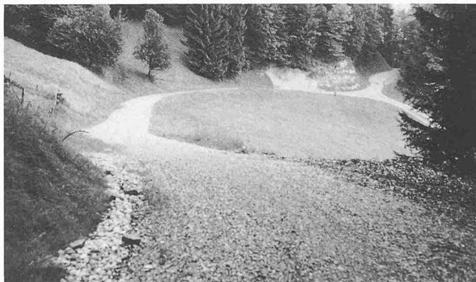
Gesamtmelioration in der voralpinen Hügelize: Basisweg zur Erschliessung von Feld und Wald
