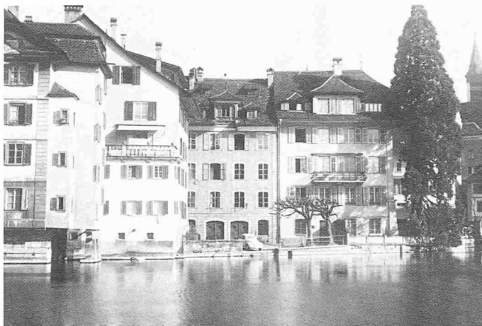
Fassadenaufnahme schutzwürdiger Altstadtbauten
