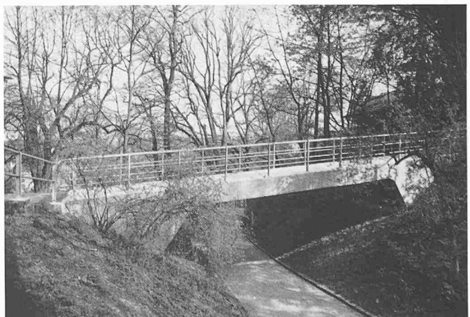
Sanierung einer Stahlbetonbrücke von Ingenieur Robert Maillart, die in den zwanziger Jahren erstellt wurde.
