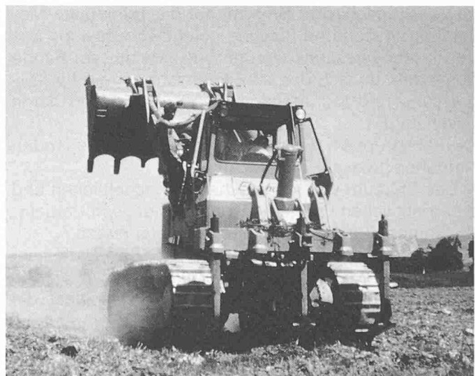
Sanierung verdichteter Böden entlang der Autobahnen: Einsatz eines Untergrundlockerers
