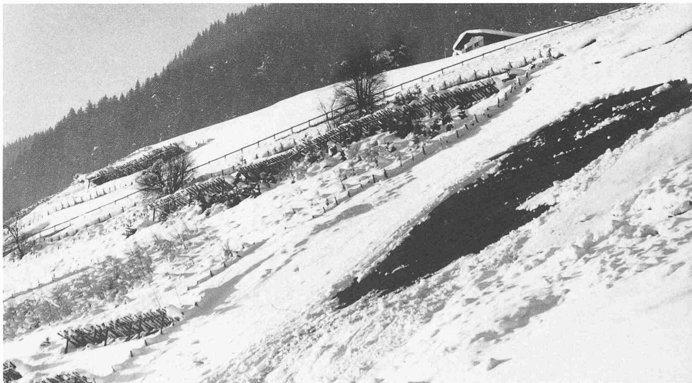
Schutzlos wird jedes natürlich angeflogene Pflänzlein Jahr für Jahr ausgerissen. Ein Anrissverbau aus Holz sorgt während 15 bis 30 Jahren für den Schutz der Strasse sowie der Jungpflanzen. Das etappenweise Vorgehen erlaubt die Beobachtung der Resultate und eine Optimierung der Massnahmen. In wenigen Jahren wird die Frage gestellt werden, ob dies wirklich ein Schutzwald für die Strasse oder einfach irgendein Waldstück sei.
