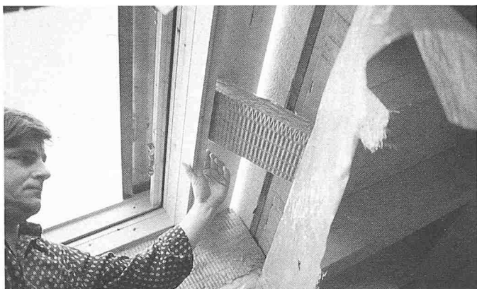
Bild 6. Richtig: Wärmedämmung einpassen zwischen Dachschalung und Fensterrahmen
