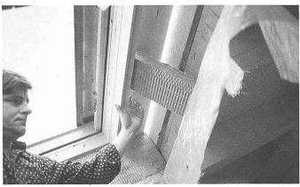
Bild 6. Richtig: Wärmedämmung einpassen zwischen Dachschalung und Fensterrahmen
