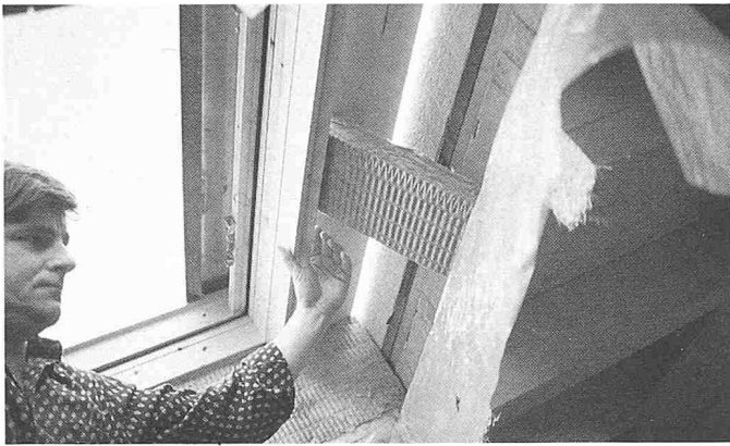
Bild 6. Richtig: Wärmedämmung einpassen zwischen Dachschalung und Fensterrahmen
