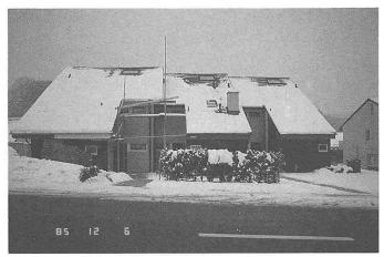
Typisches Bild von Dächern bei unzulänglicher Wärmeisolation um Dachflächenfenster
