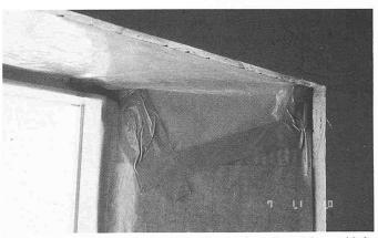
Bild 7. Richtig: Dampfsperre bis an den Fensterrahmen hochziehen und luftdicht dort anschliessen. Ecken sorgfältig ausbilden und verkleben
