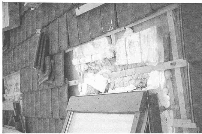
Bild 2. Falsch: Isolationsmaterial stark gestopft - reduziert dessen Wirksamkeit. Infolge fehlender Unterlüftung bleibt das Kondenswasser in der Wärmedämmung und tropft schliesslich ins Hausinnere zurück
