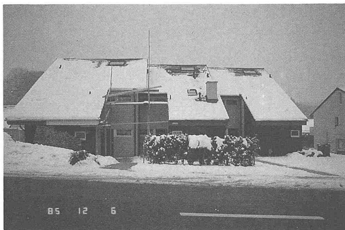
Bild 1. Typisches Bild von Dächern bei unzulänglicher Wärmeisolation um Dachflächenfenster
