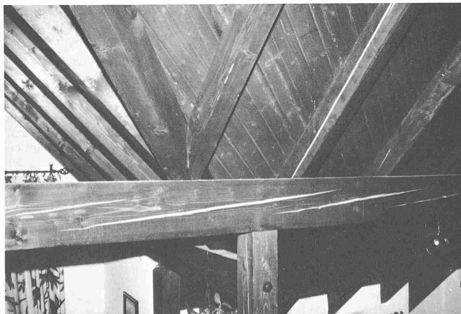
Bild 1. Sehr stark störende nachträgliche Rissbildung des Konstruktionsholzes eines ausgebauten Dachgeschosses
