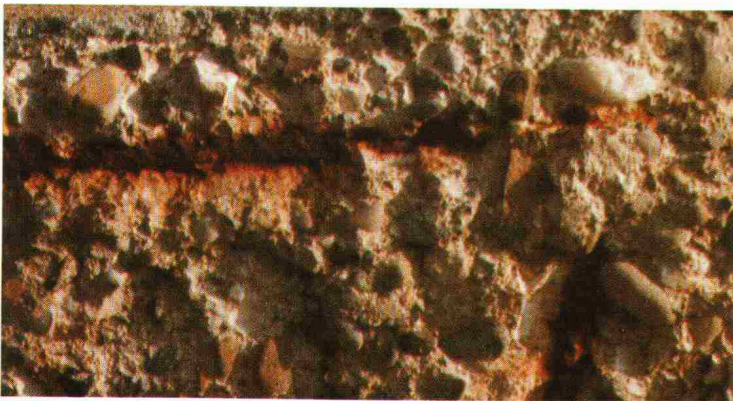
Betonabplatzungen infolge starker Armierungskorrosion.
