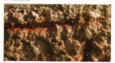
Betonabplatzungen infolge starker Armierungskorrosion.
