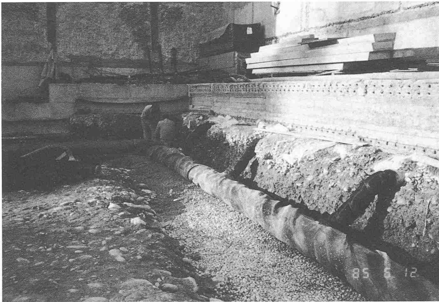
Bild 4. Ringdrainage (Sickerbetonstreifen, Längsdrainagerohr und Quersaugrohre mit Filtergewebeamantlung)
