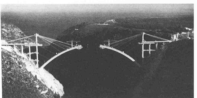
Bild 8. Freivorbau mit rückwärtiger Abspannung
