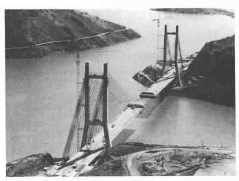
Bild 10. Schrägseilbrücke als Vielseilsystem
