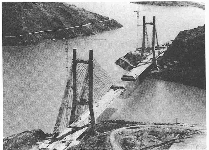
Bild 10. Schrägseilbrücke als Vielseilsystem
