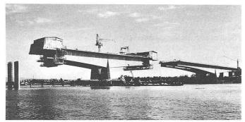
Beim freien Vorbau stützen sich die freitragenden Gerüste auf das Tragwerk selbst
