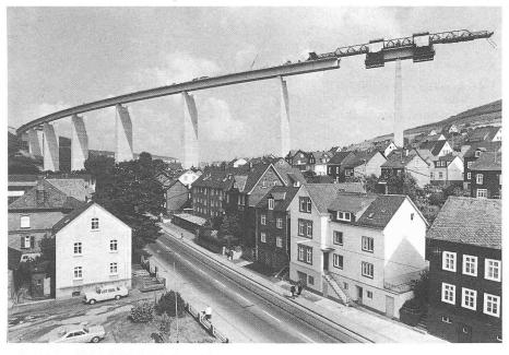
Bild 4. Abschnittweiser Vorschub der Brücke
