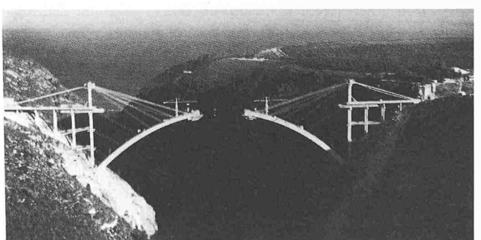
Bild 8. Freivorbau mit rückwärtiger Abspannung
