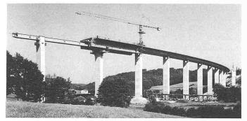
Bild 2. Vorschubgerüste für den feldweisen Bau
