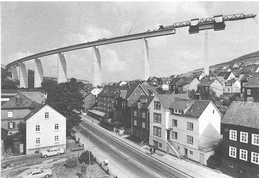
Bild 3. Kombination von Vorschubgerüst und Freivorbau
