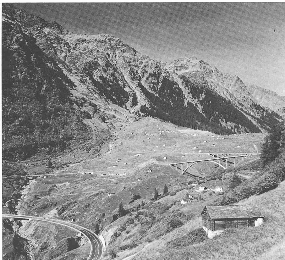
Bild 1. Mit dem Bau eleganter, den Formen des Geländes angepassten Brücken wurde es überhaupt erst möglich, in den steilen Talabfall des Miso (GR) die Nationalstrasse N 13 so zu bauen, dass sie heute die Landschaft kaum belastet
