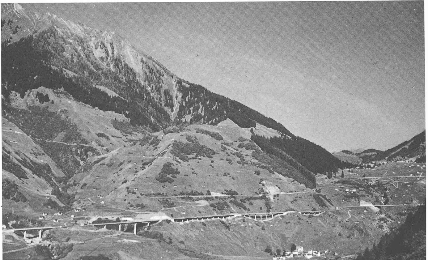
Bild 3. Dank dem Bau von hangparallelen Brücken und Lehenbrücken konnte im steilen, rutschigen Hang oberhalb Mesocco auf riesige Stütz- und Futtermauern verzichtet werden
