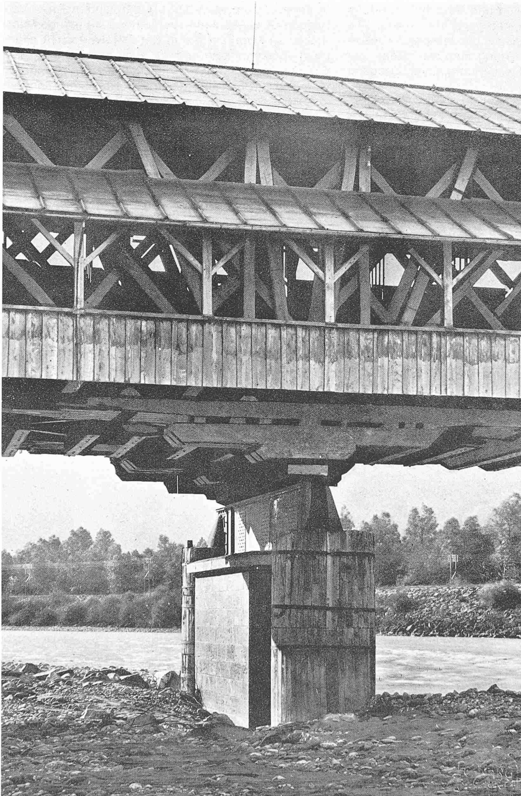
Eisenbahnbrücke über den Rhein bei Ragaz, erbaut 1856 Spannweite der grössten Öffnung: 24 m
