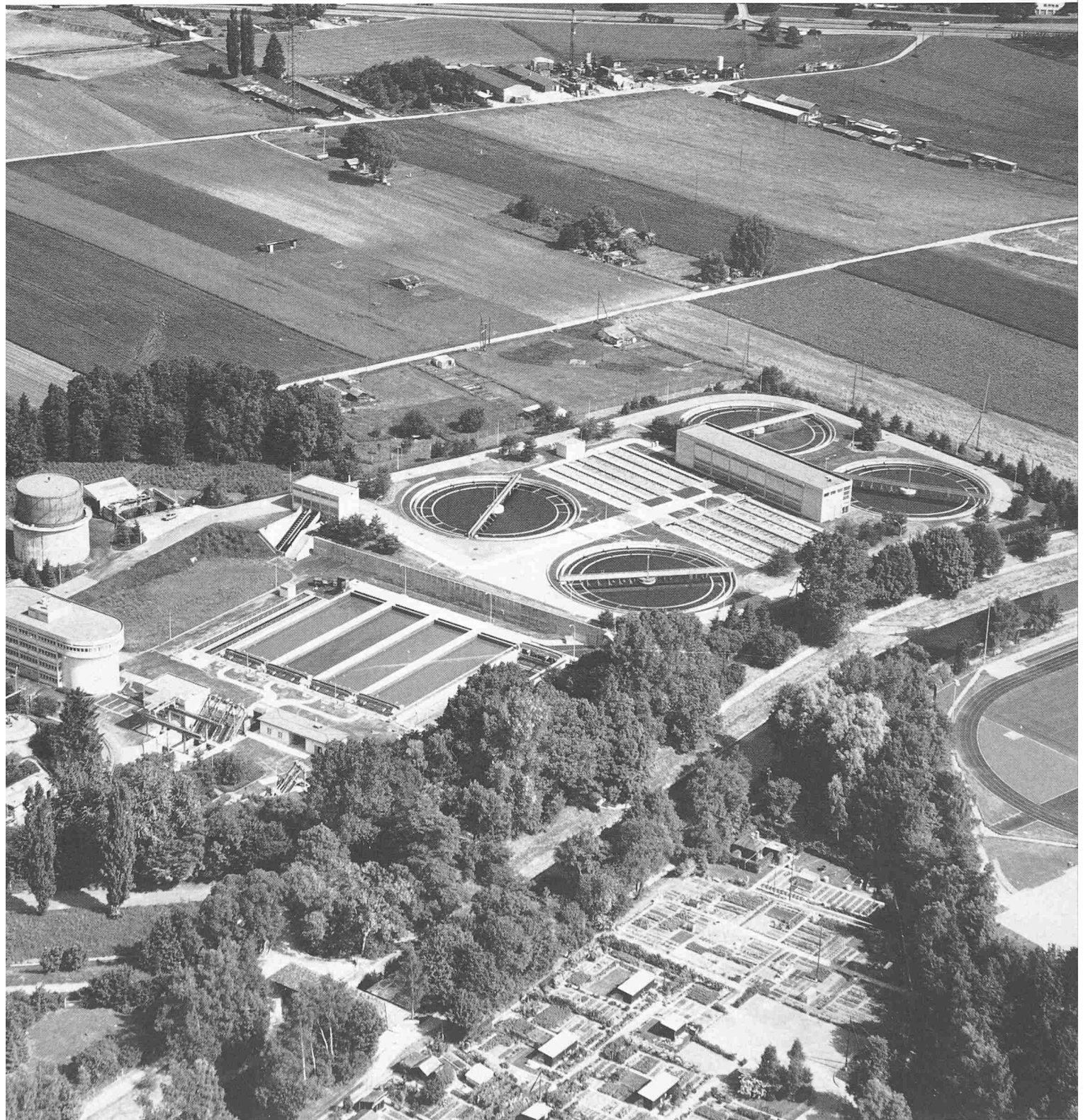
Abwasser-Reinigungsanlage Leutschenbach, Zürich
