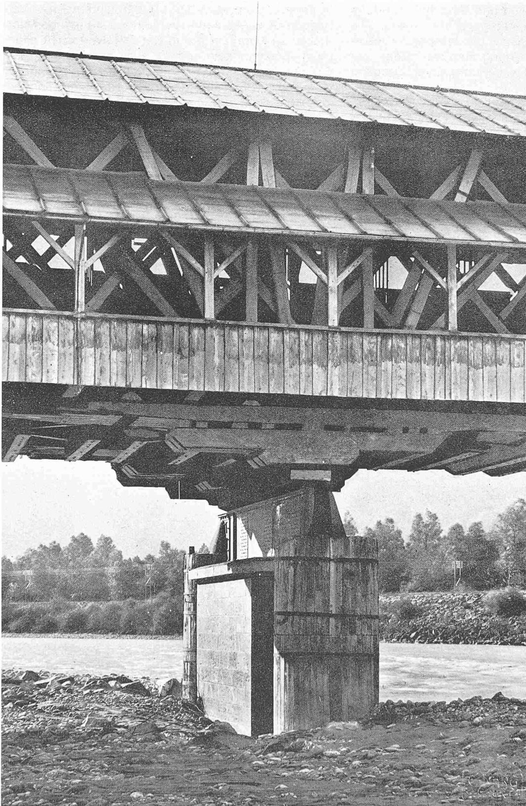
Eisenbahnbrücke über den Rhein bei Ragaz, erbaut 1856 Spannweite der grössten Öffnung: 24 m
