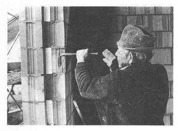
Bild 2. Vermessungstechnische Präzisionsinstrumente werden nicht benötigt. Hier ist die Ebenheits-Toleranz überschritten
