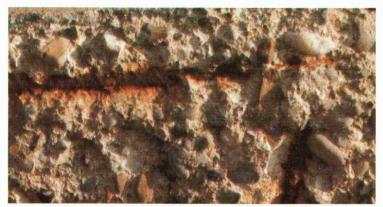
Betonabplatzungen infolge starker Armierungskorrosion.
