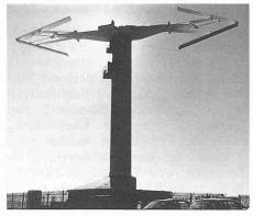
Wie eine riesige, H-förmige Fernsehantenne sieht die 135-kW-Windturbine in Wales aus, ein im Rahmen des britischen Forschungsprogramms für Windenergie entwickelter Prototyp
