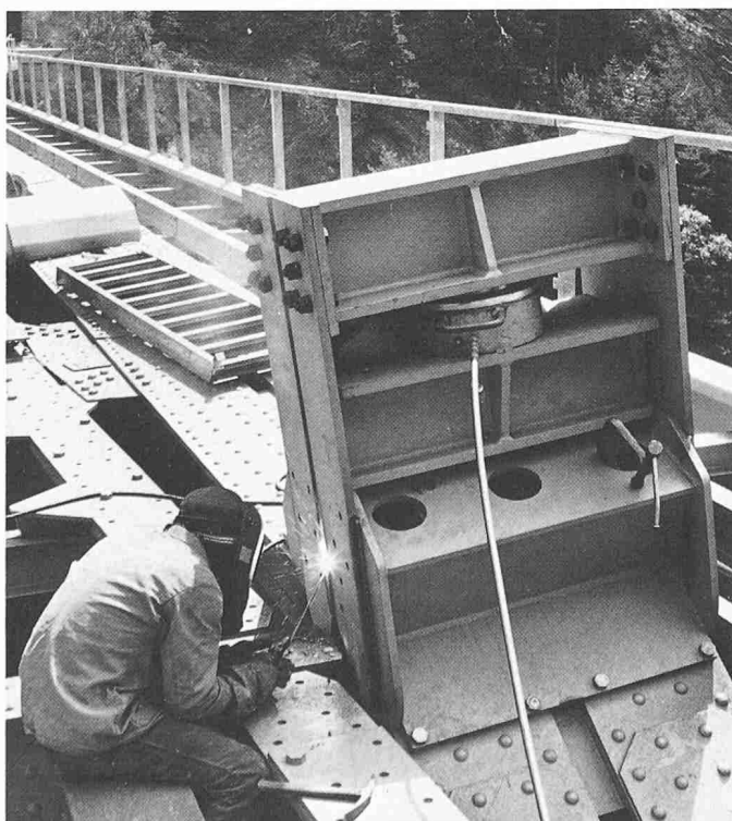
Bild 4a. Gurtknickpunkt am Auflager-Knoten 3: Ober- und Untergurte gegenüberliegender Traversen sind durch Spannstrangen miteinander verbunden
