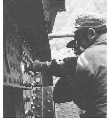
Bild 8c. Nietarbeiten
