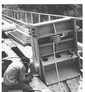
Bild 4a. Gurtknickpunkt am Auflager-Knoten 3: Ober- und Untergurte gegenüberliegender Traversen sind durch Spannstangen miteinander verbunden
