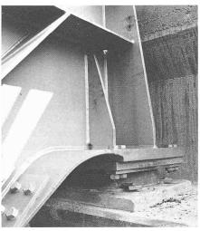
Bild 8b. Auflagerknoten der neuen Vorbrücken (Schweisskonstruktion)
